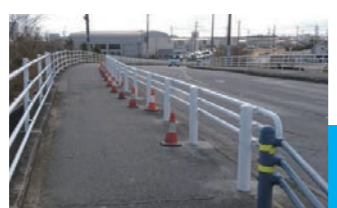
木田橋から神戸中学校橋を通って 十宮地区までのガードパイプ並び に対面通行の表示を設置
