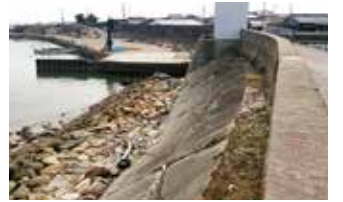
若松地区堤防調査
