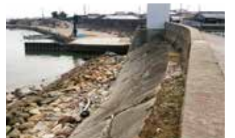
若松地区堤防調査
