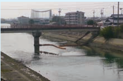
■堀切川護岸整備
