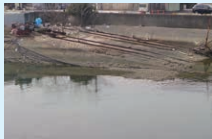
■堀切川河床整備
