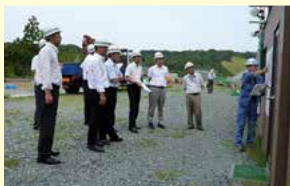
■「国道167号バイパス」 建設現場にて状況説明
