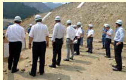
■尾鷲熊野道路「いのちの道」 建設現場視察
